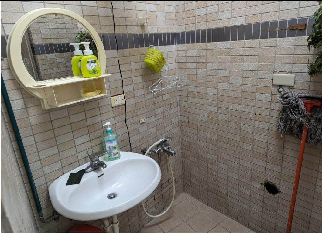
1（女警待勤室浴廁施工前）
