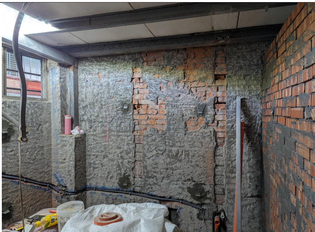
7 (1樓廁所施工中)
