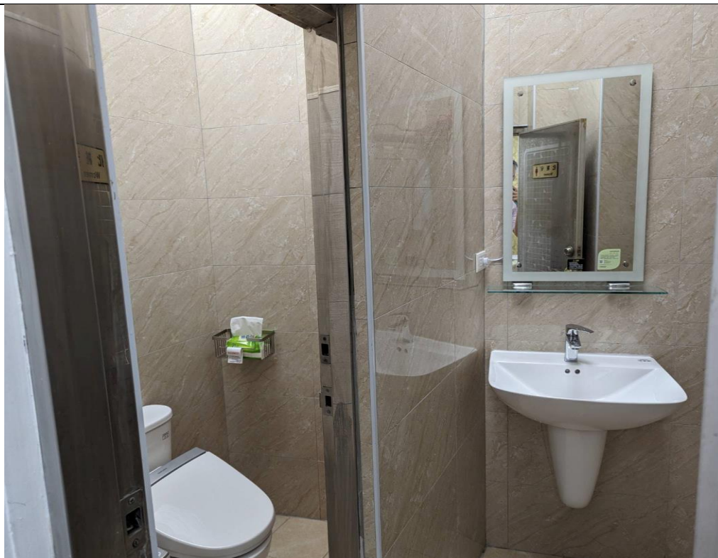
9（女警待勤室浴廁施工後）
