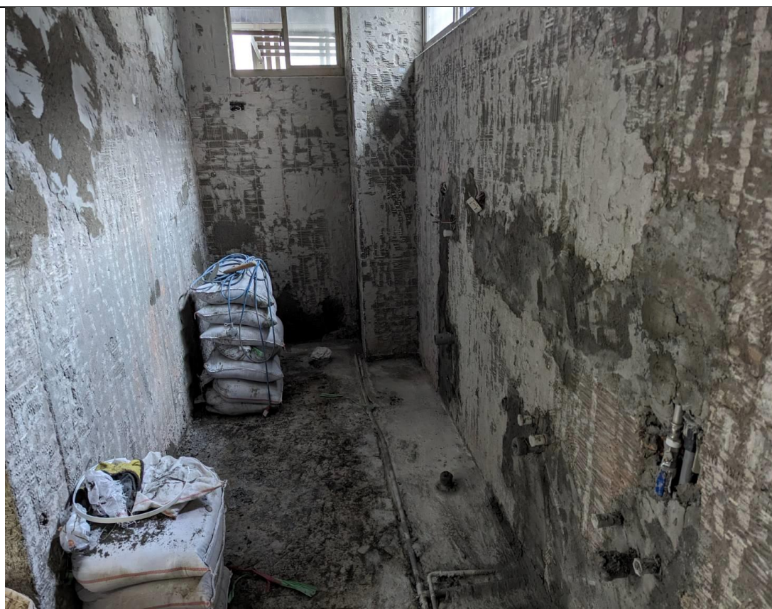
8 (3樓待勤室浴廁施工中)
