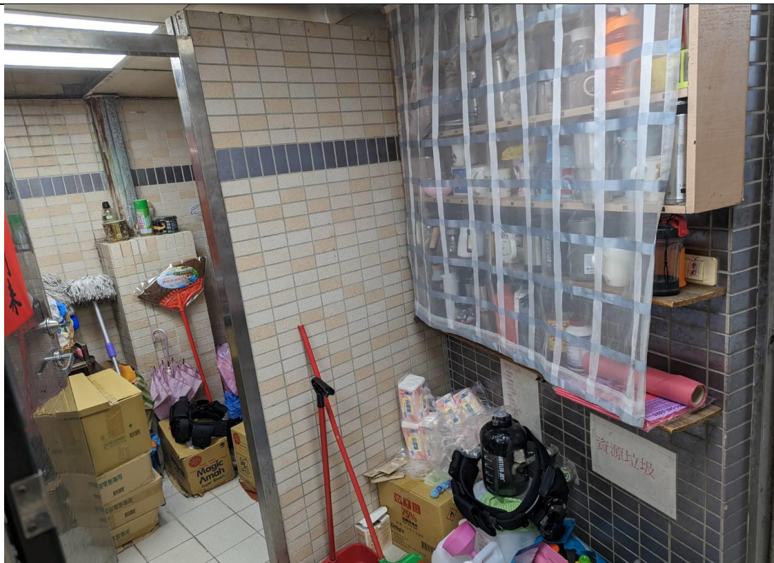
3 (1樓廁所施工前)
