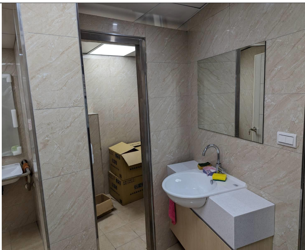
10（1樓廁所施工後）
